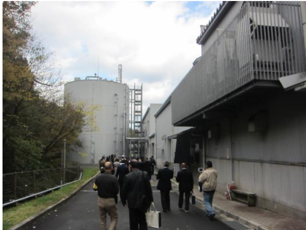
ถังหมักขนาดใหญ่เพื่อผลิตก๊าซมีเทน (ซ้าย) โรงงานผลิตไฟฟ้า (ขวา)
