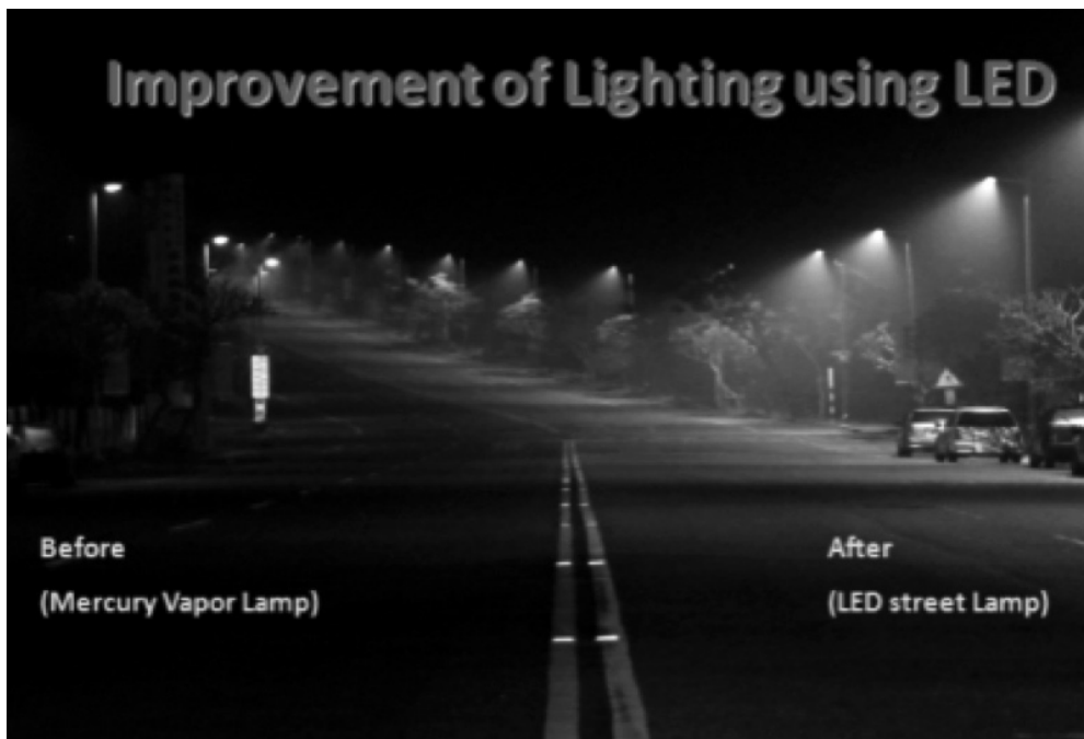
รูปที่ 1 : ภาพถ่ายเปรียบเทียบระหว่างหลอดแสงจันทร์ (Mercury Vapor Lamp) และหลอด LED
