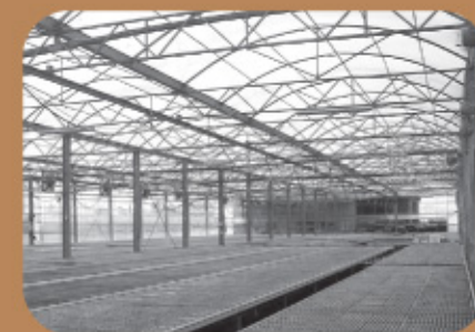
โรงเรือนหลังคาสูงทำให้ระบายถ่ายอากาศได้ดี
