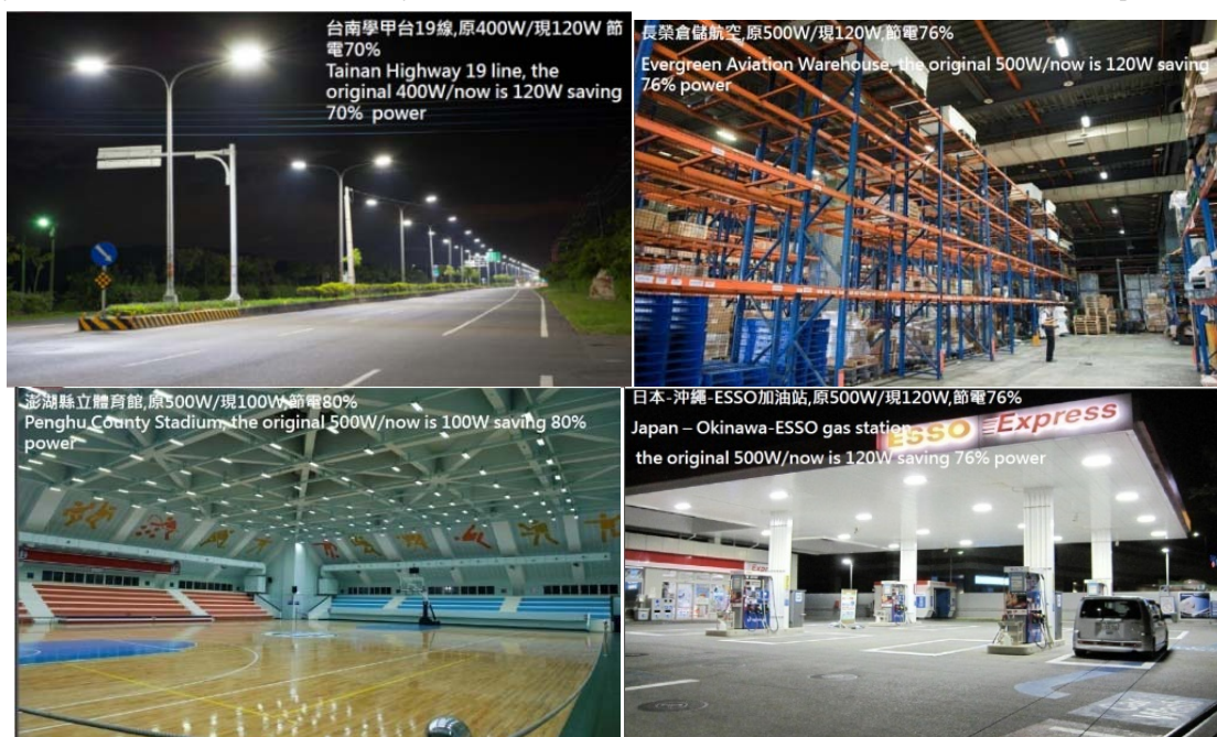
รูปที่ 31 เปรียบเทียบผลการประหยัดพลังงานไฟฟ้าหลังจากเปลี่ยนมาใช้หลอดและคอม LED
