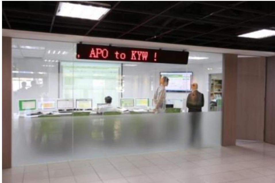
ห้อง Control เพื่อใช้ Real time monitoring ข้อมูลของลูกค้า
