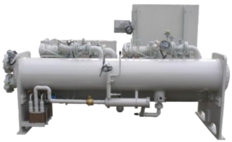
เครื่องจักรต้นแบบของ AMB bearing Chiller
